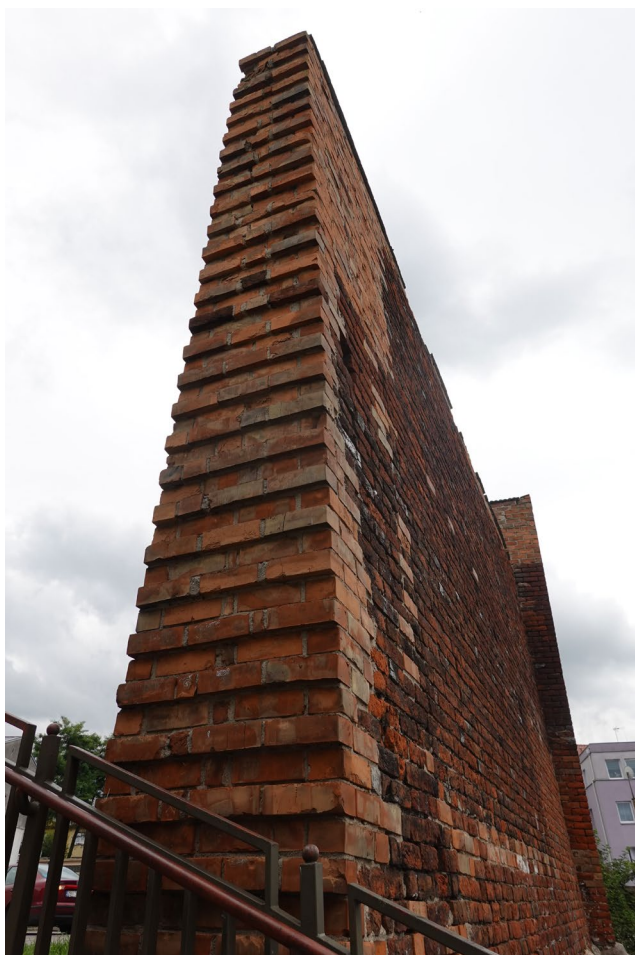
Fot.16 Ładnie zamknięte współcześnie strzępia muru.
