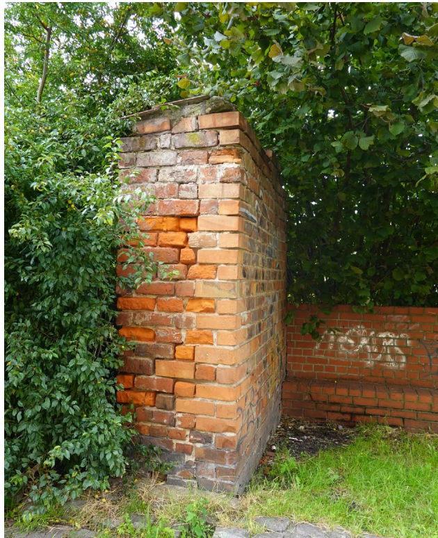
Fot.1 Słupek ceglany wtórnie przemurowany
