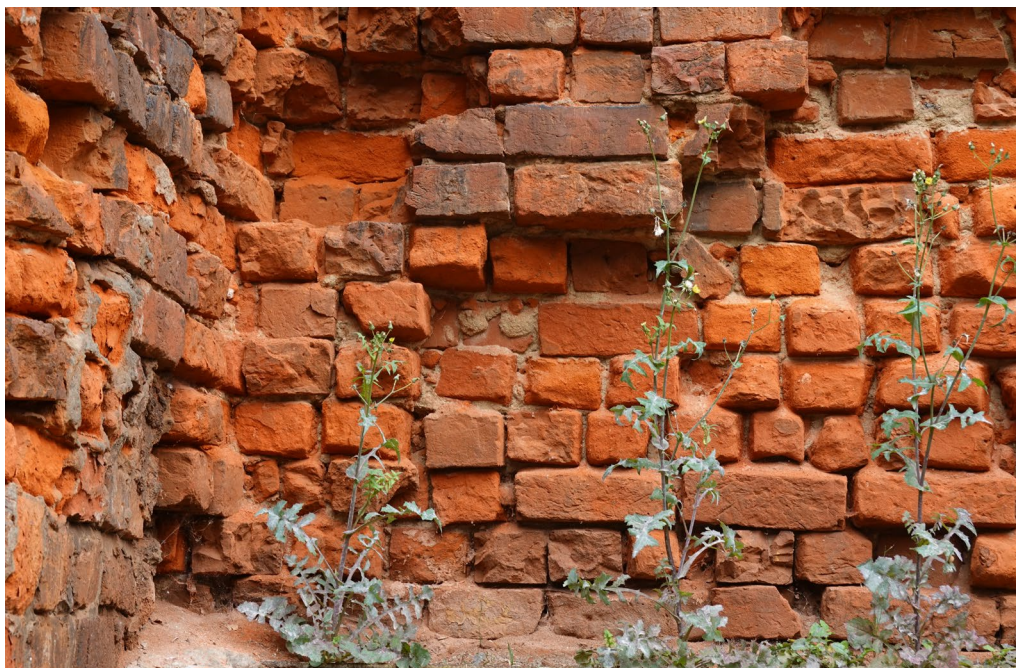
Fot.9 Bardzo osłabiony fragment muru z zakażeniem bakteryjnym. Poluzowany materiał ceramiczny
