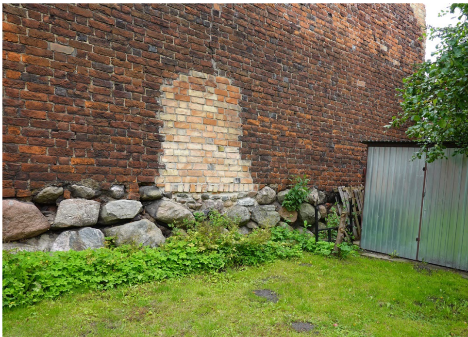
Fot.21 Zamknięcie wewnętrznego odcinka muru. Przymurowanie ze współczesnej cegły.
