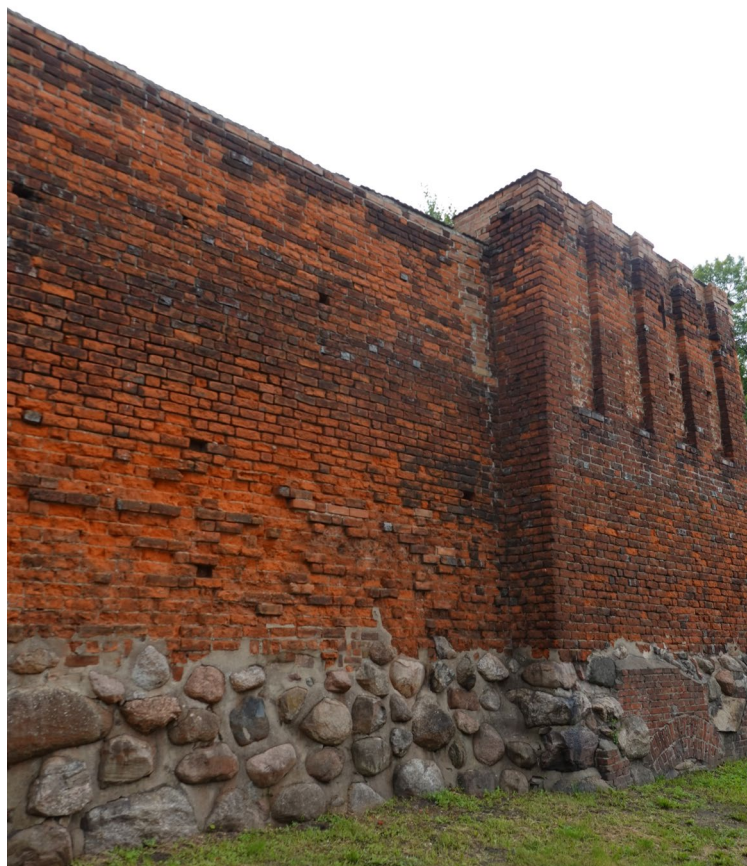
Fot.8 Wewnętrzna partia muru z cokołem granitowym
