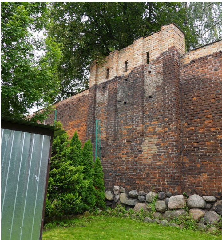
Fot.19 Odcinek muru podzielony działką prywatną. Widoczna nadbudowa ze współczesnej cegły.
