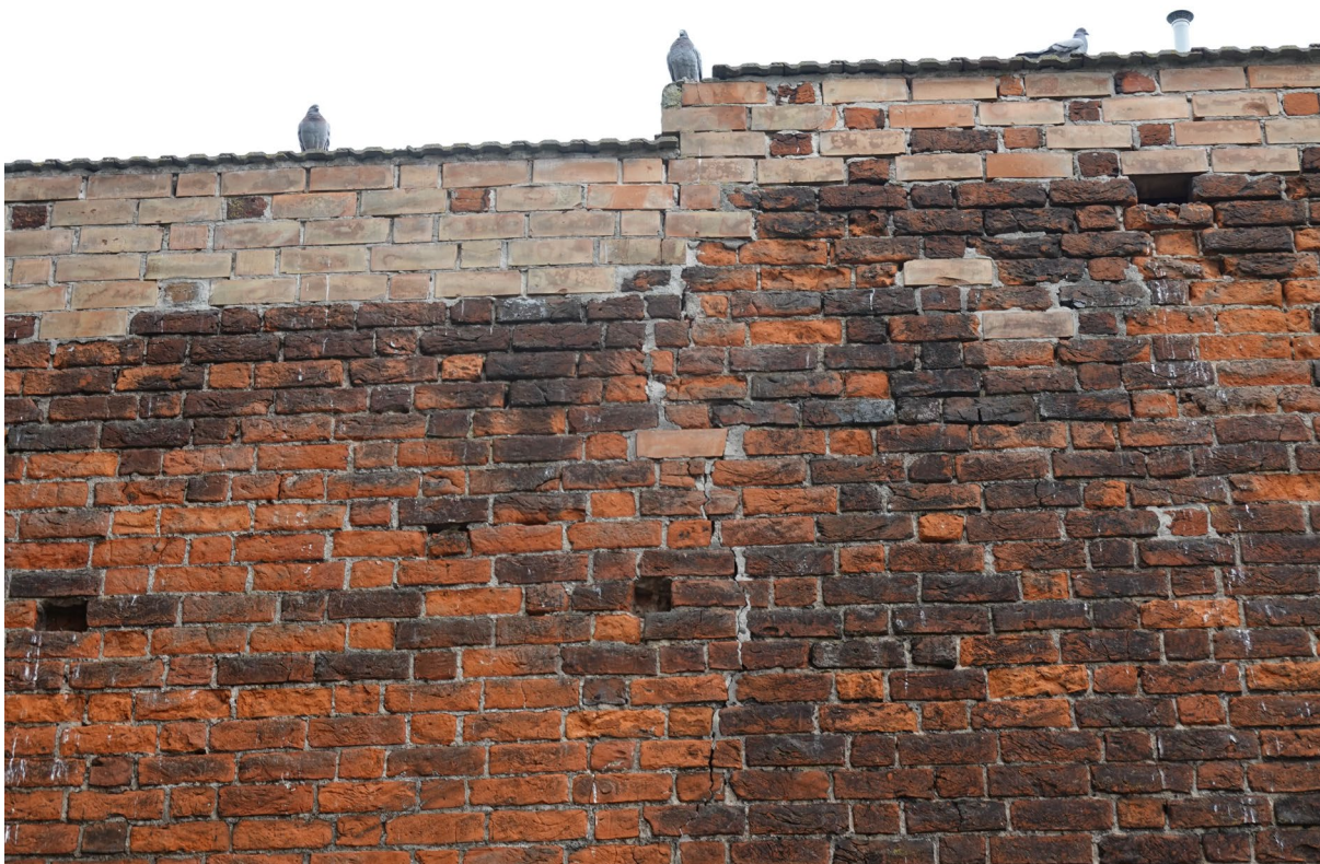
Fot.18 Zanieczyszczenia smółkowe cegieł, współczesna korona murów.
