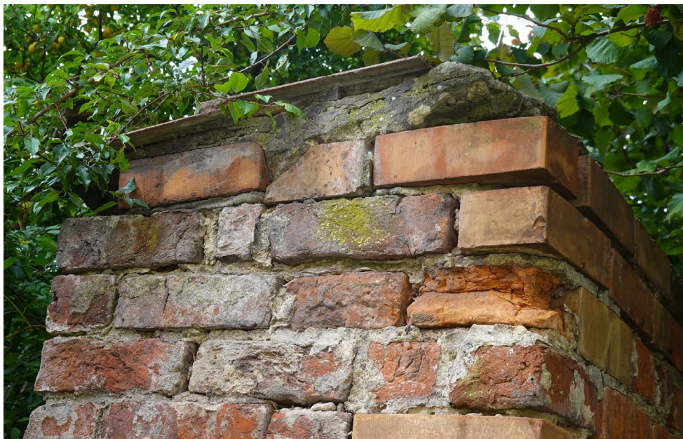
Fot.3 Silnie wysolony górny fragment słupa.
