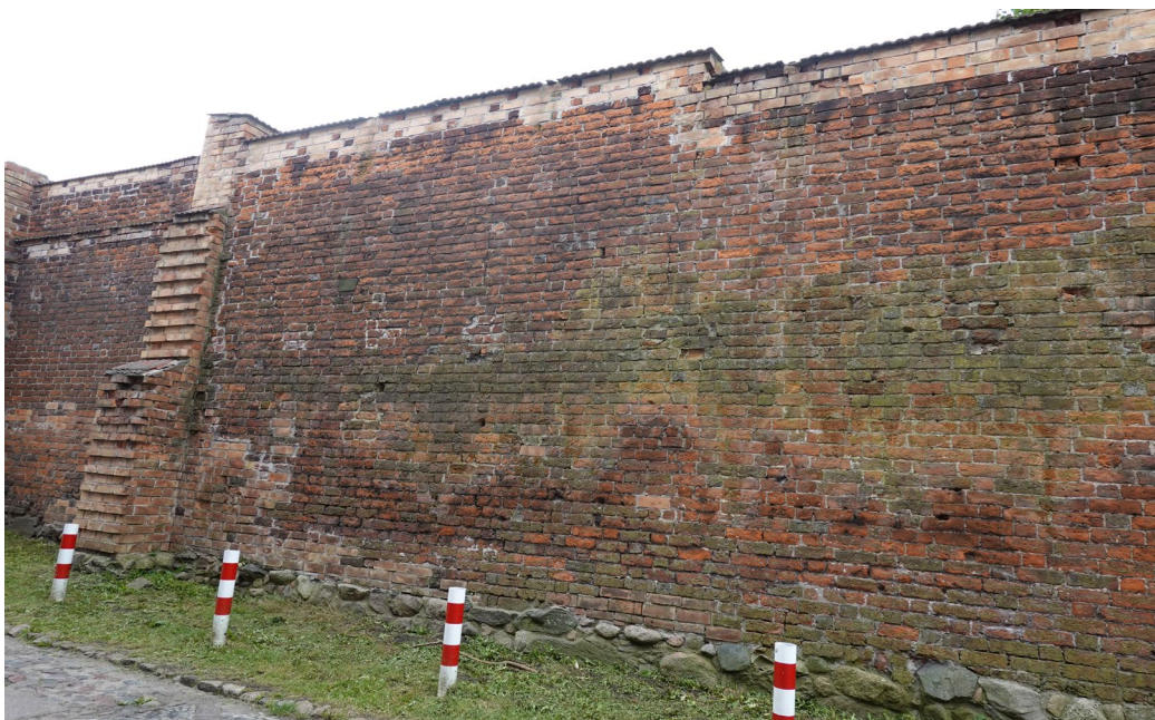
Fot.7 Widoczne silne zawilgocenie i zakażenie biologiczne muru.
