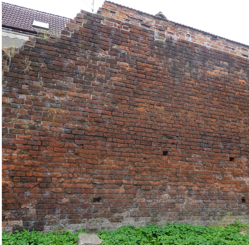
Fot.3 Nadbudowa muru ze współczesnej cegły zakmnięta dachówką.
