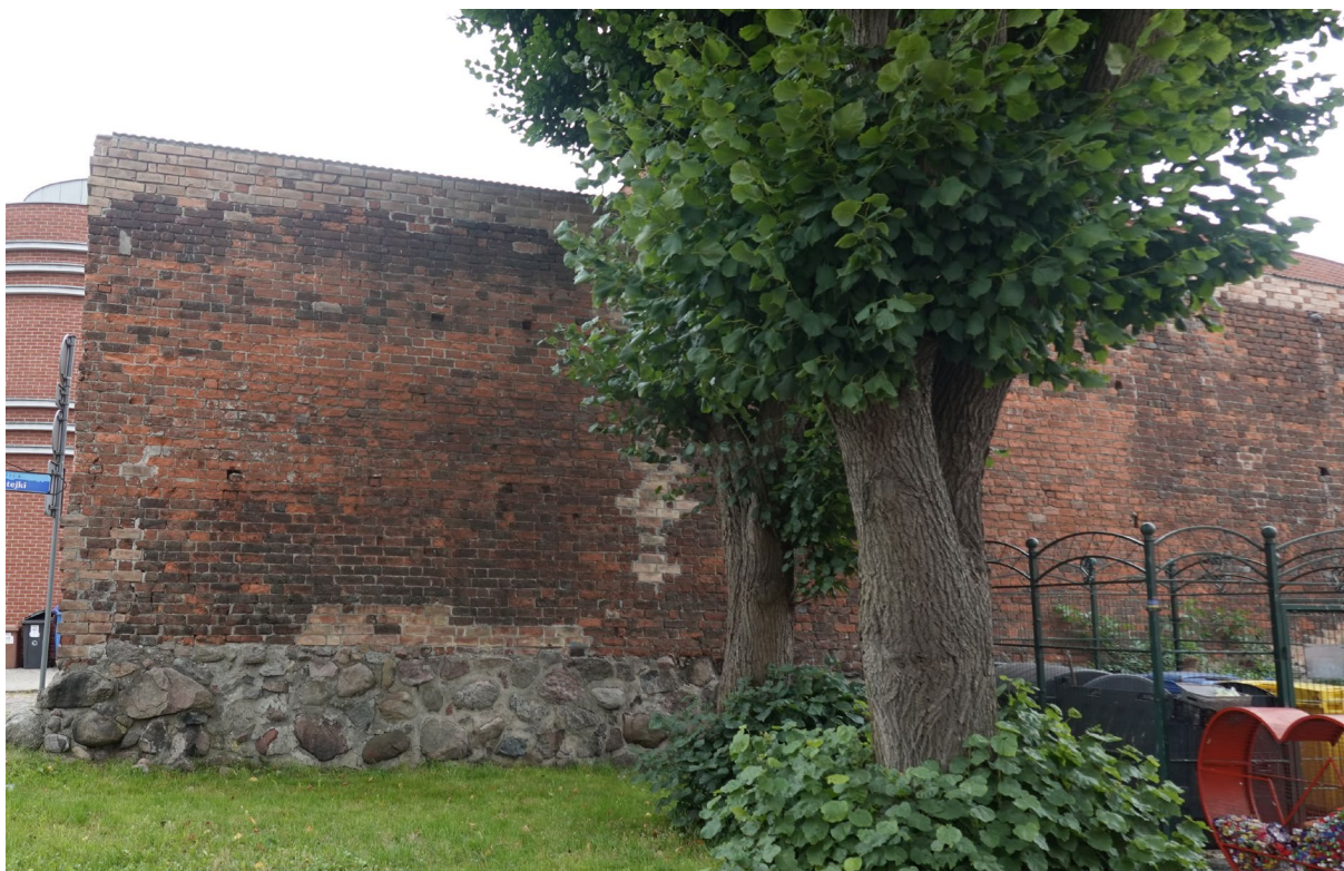
Fot.11. Widoczne zanieczyszczenia na ceglach oraz współczesna nadbudowa korony murów. Drzewa przylegające blisko do muru.
