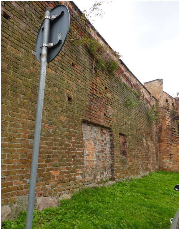
Fot.9 Silnie zanieczyszczony odcinek oraz zaatakowany biologicznie
