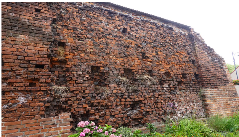
Fot.11Bardzo duże ubytki spoin oraz cegły w murze.
