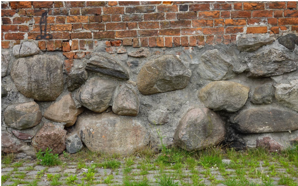
Fot.15 Zbliżenie na cokołową partię granitową. Wtórna spoina cementowa.
