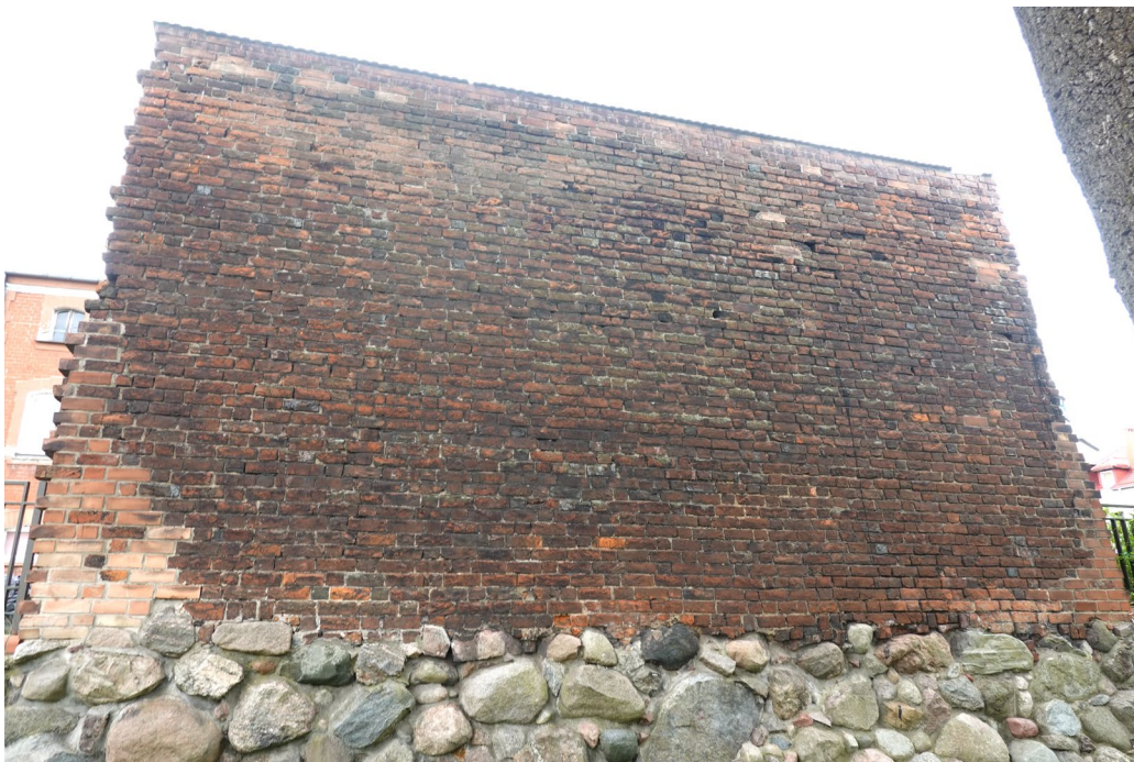
Fot.4 Widok na całą tylną część muru, współczesne uzupełnienia cegły
