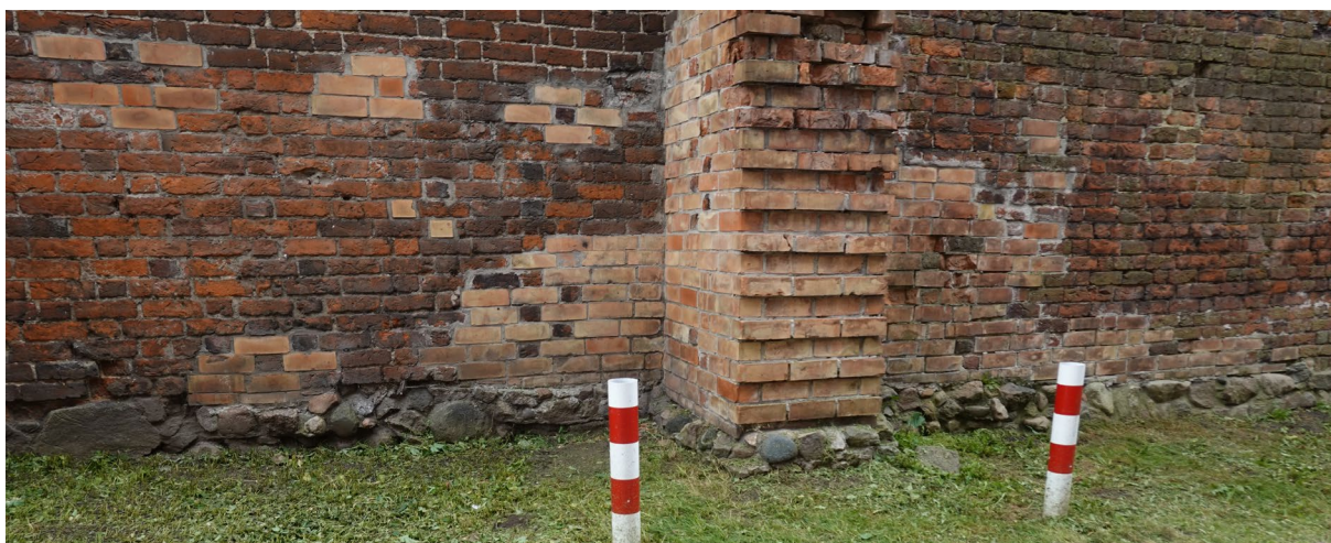
Fot.6 Partia niskiego cokołu z widocznym cokołem granitowym. Grunt przylegający bezpośrednio do muru.
