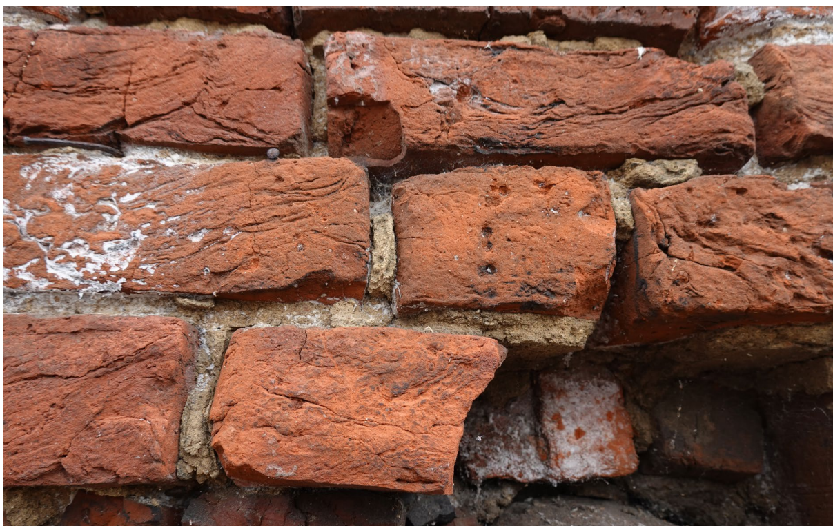
Fot.23 Zachowane stare spoiny muru. Widoczne wysolenia na ceglach.
