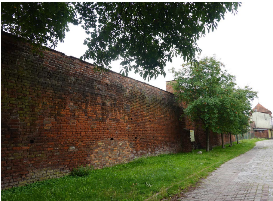
Fot.5 Końcowy pas muru w kierunku krótkiego odcinka. Roślinność przylegająca zbyt blisko muru.
