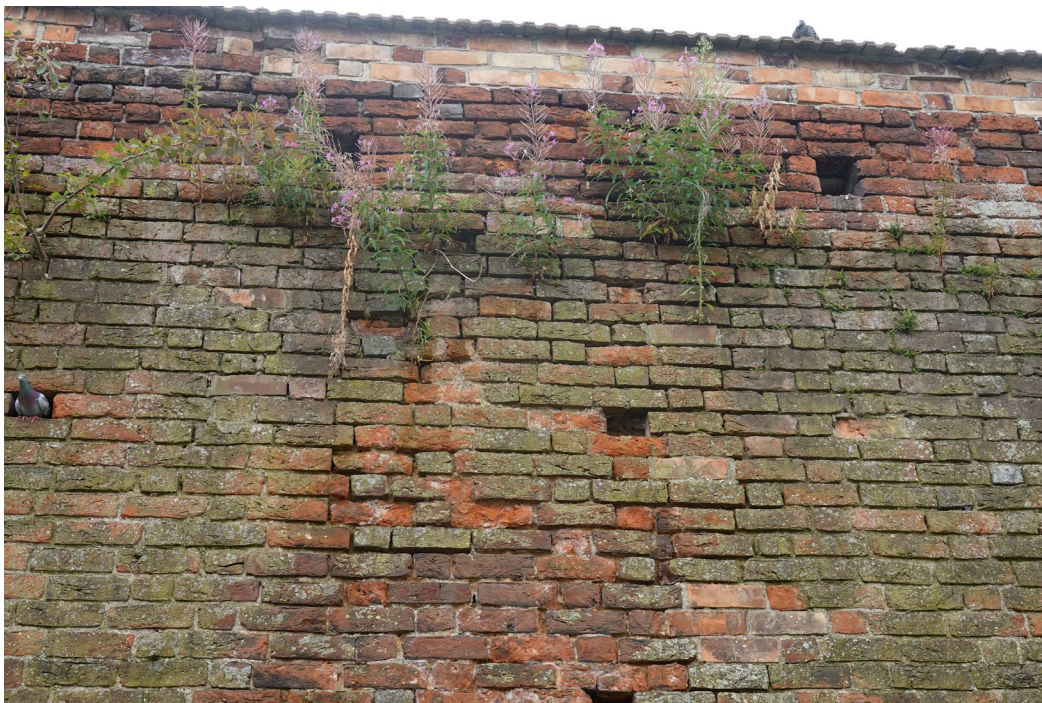
Fot.10 Zielone przebarwienia biologiczne, wtręty roślinności, poluzowanie materiału
