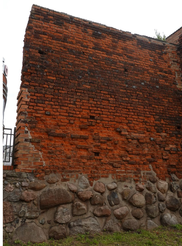
Fot.6 Ubytki partii cokołowej muru, silne zanieczyszczenia smólkowe środkowej partii muru
