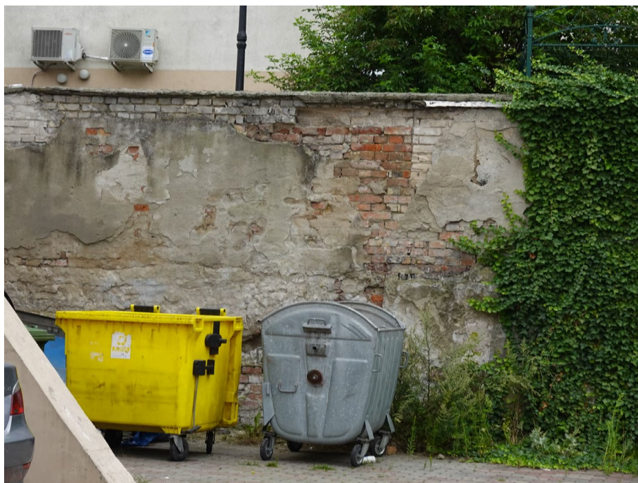
Fot.1 Fragment muru na podwórku – w większości zatynkowany oraz przemurowany, nie kwalifikujący się do ekspozycji cegły..
