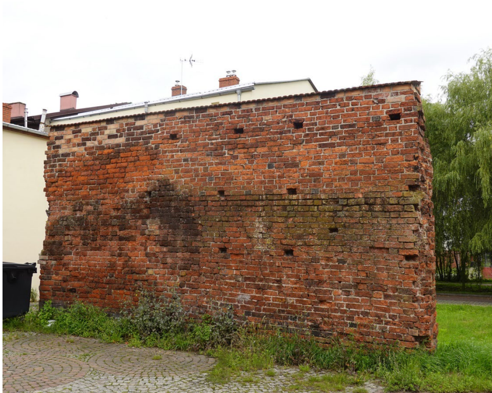
Fot.2 Mur od strony ulicy. Silne zawilgocenie, roślinność porastająca zbyt blisko muru.
