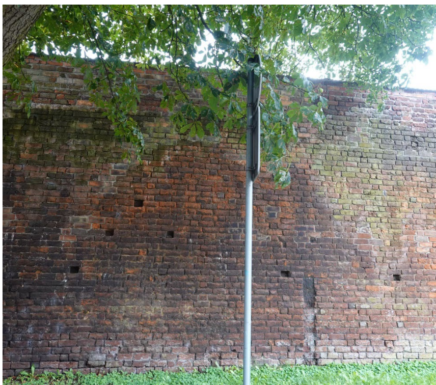
Fot.4 Czarne zanieczyszczenia na partiach cegieł. Zasolenie cokołowego pasa muru.
