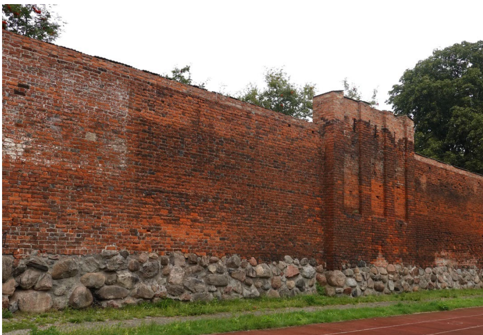
Fot.14 Cokołowa partia granitowa. Widoczne nadbudówki ze współczesnej cegły.
