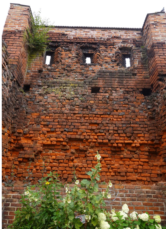
Fot.10 Centralna część muru. Pudrowanie materiału.
