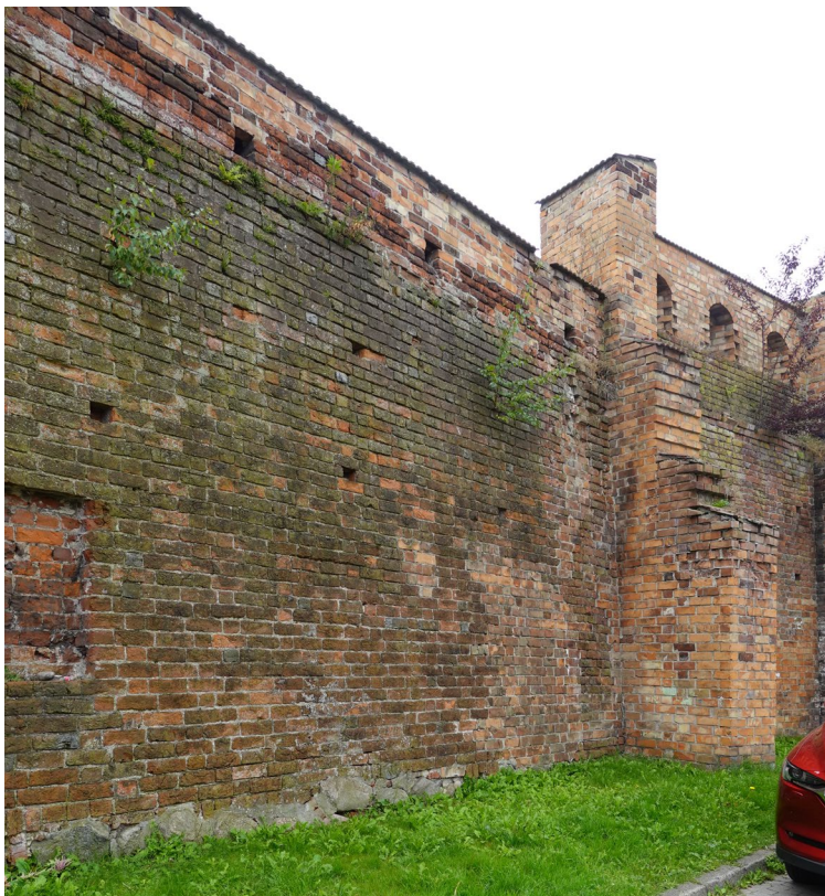
Fot.12 Zróżnicowanie muru: zanieczyszczenia, przebarwienia biologiczne, współczesne wstwy
