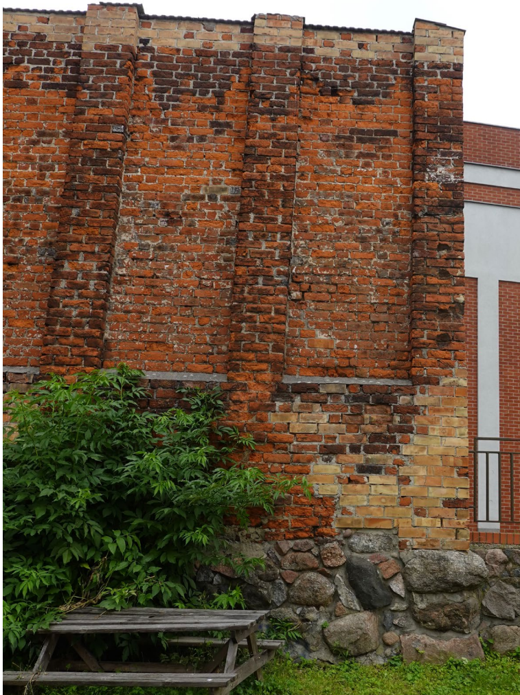
Fot.14 Widoczny cokół granitowy oraz współczesne przemurówki w partii korony murów oraz nad cokołem granitowym
