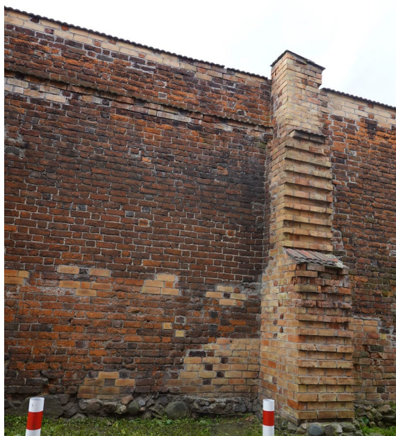
Fot.4 Środkowa część muru. Przemurowania w partii przypory.
