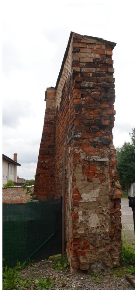
Fot.4Drugi bok muru zasmarowany zaprawą cementową.
