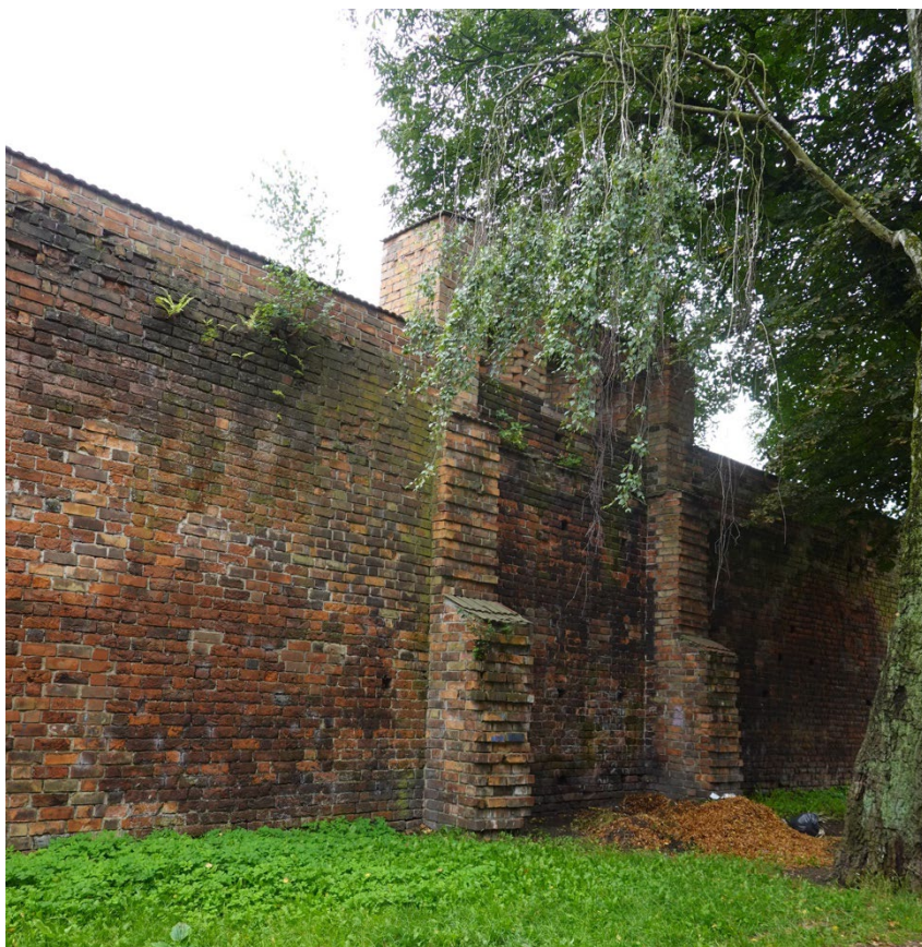
Fot.3 Widoczna środkowa partia muru od strony ulicy. Roślinność porastająca zbyt blisko muru.
