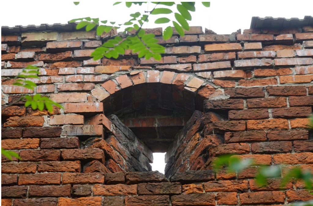
Fot.7 Nadbudowana partia muru ze współczesnej cegły osłonięta dachówką cementową.
