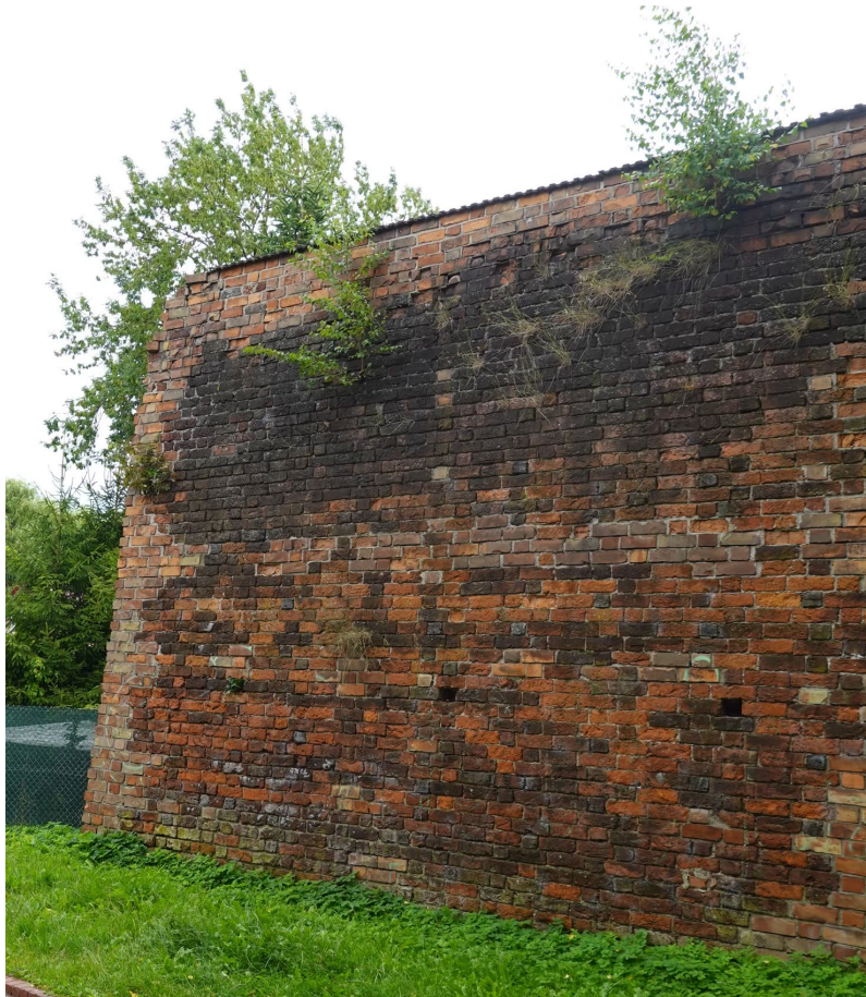
Fot.2 Widoczna wrośnięta roślinność, przemurowania z nowej cegły, poluzowany materiał.
