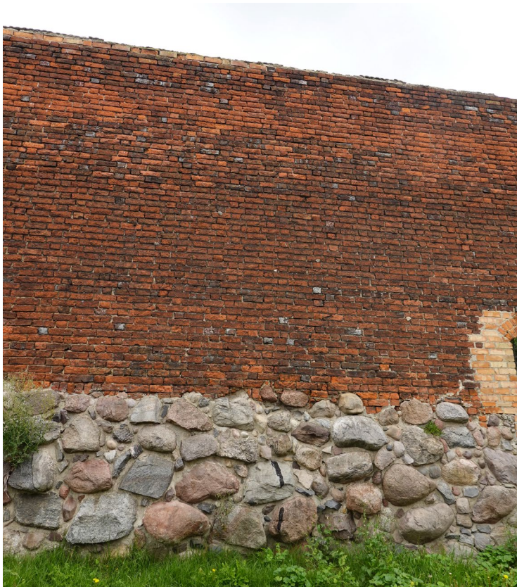
Fot.5 Wewnętrzny odcinek muru na cokole granitowym
