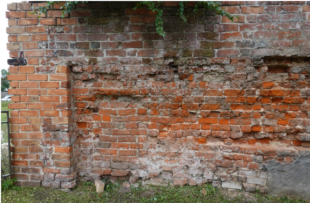
Fot.4 Silne wysolenia i degradacja muru
