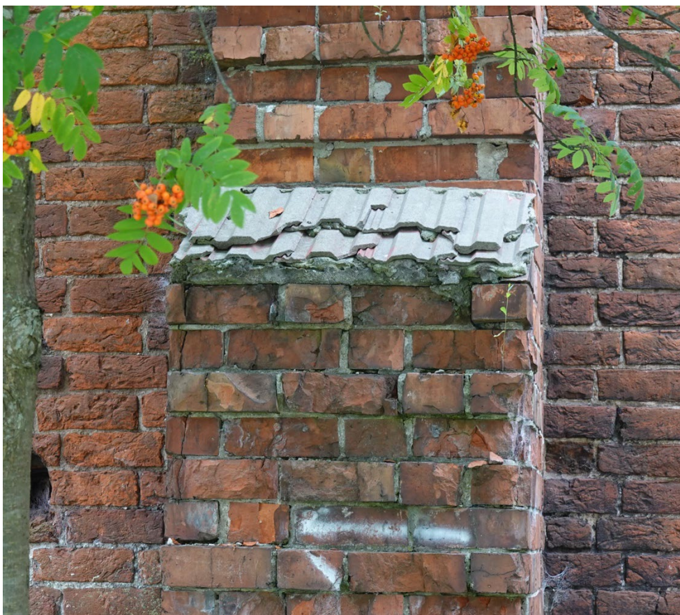
Fot.6 Wtórne dachówki cementowe osłaniające szkarpę.
