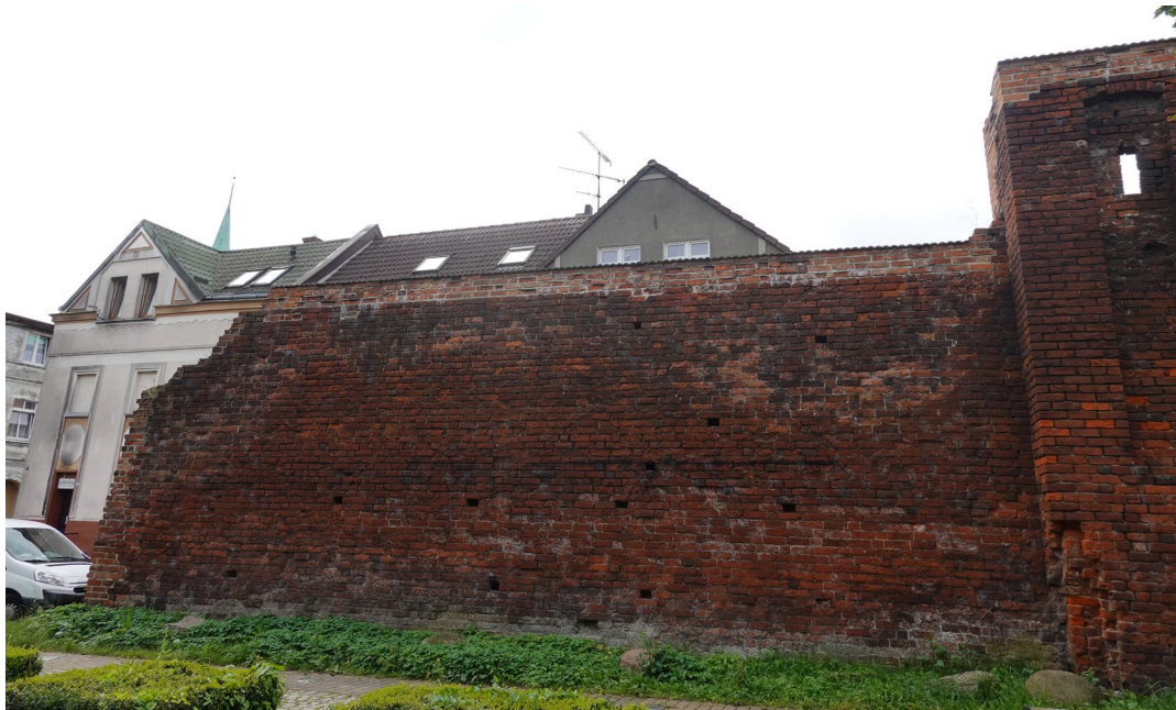
Fot.7 Mur od strony parku. Silne zawilgocenie muru.
