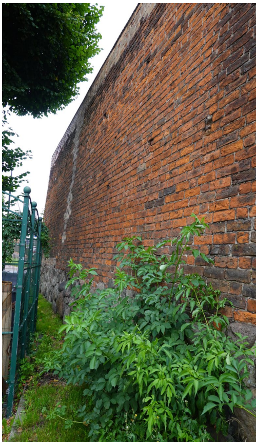
Fot.15 Zieleń przy murze wymagająca usunięcia
