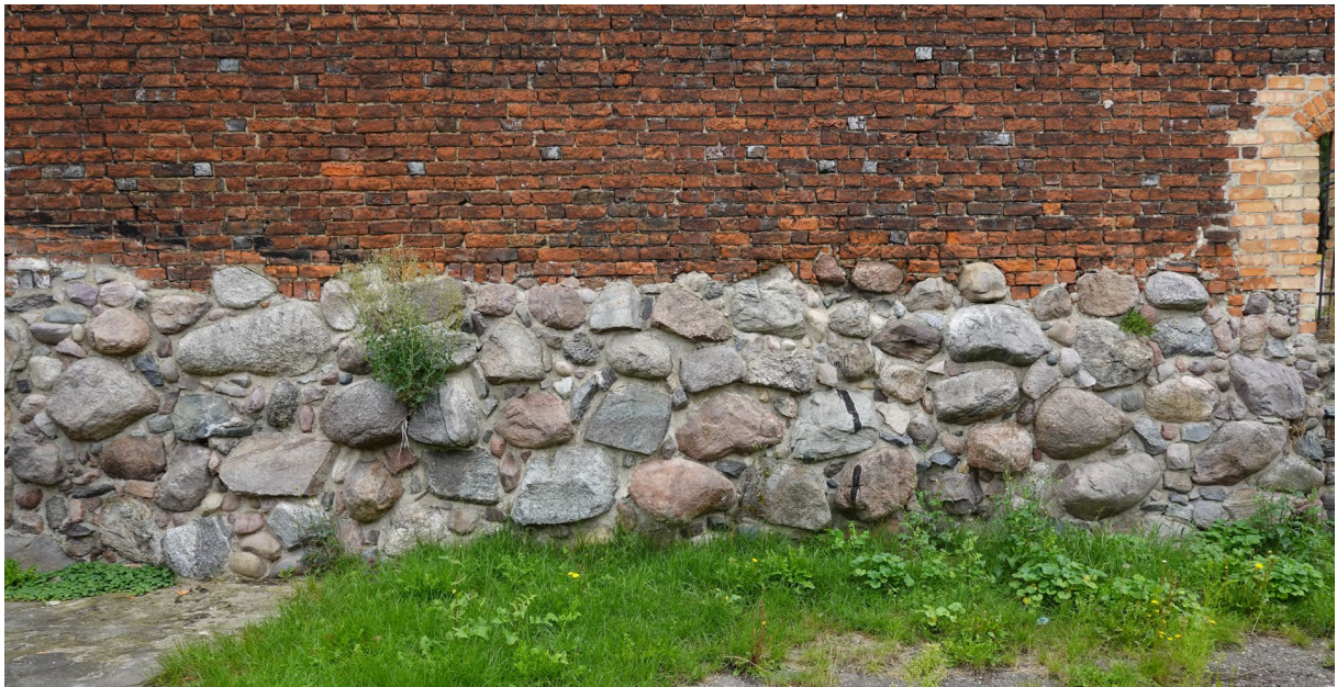
Fot.7 Partia cokołowa wewnętrznego odcinka. Widoczne współczesne przemurowanie(fragment)
