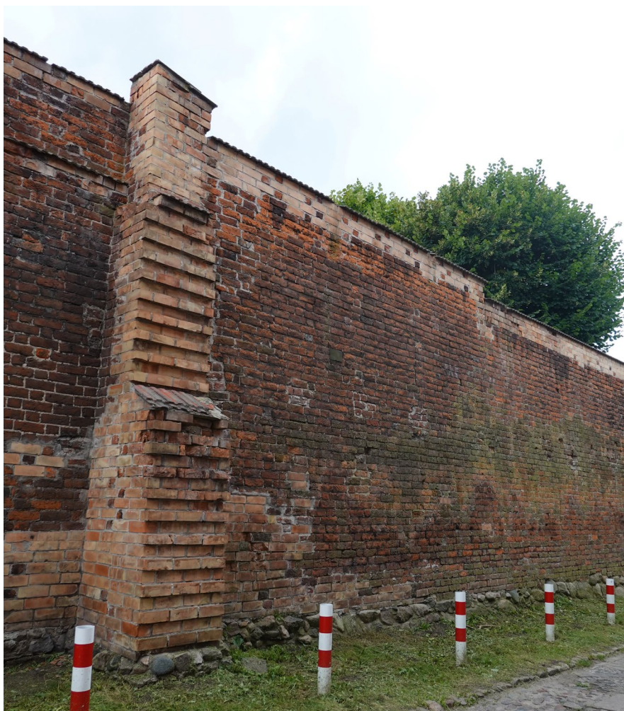
Fot.5 Silne zawilgocenie środkowej partii muru. Nadbudowa ze współczesnej cegły osłonięta dachówką.
