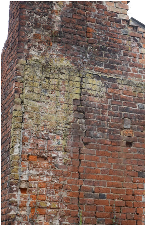
Fot.3 Silne pionowe spękanie muru, zakażenie biologiczne muru
