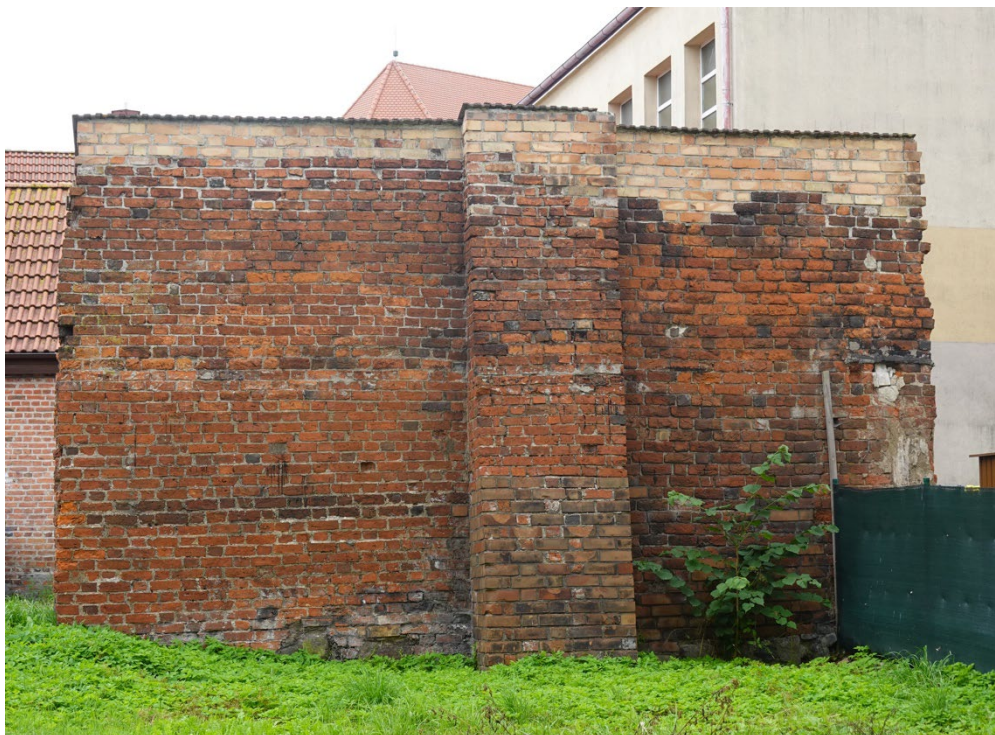
Fot.1 Mur od strony wewnętrznej. Widoczne współczesne zamknięcie korony murów z osłoną dachówek.
