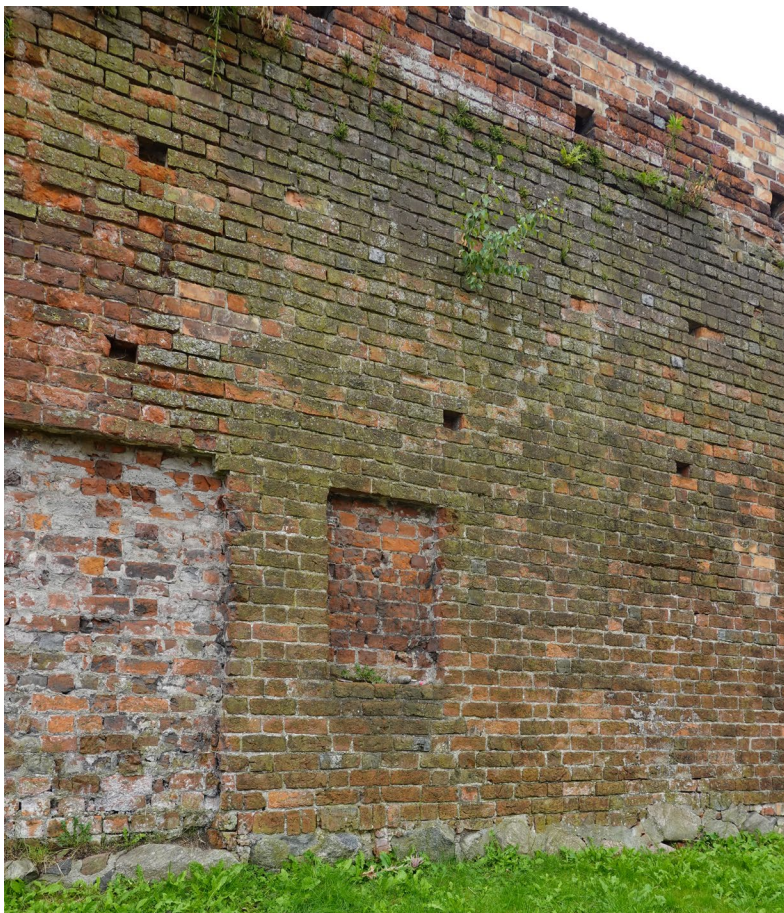
Fot.11 Wtórne wnęki muru, widoczny niski odcinek granitowy cokołu
